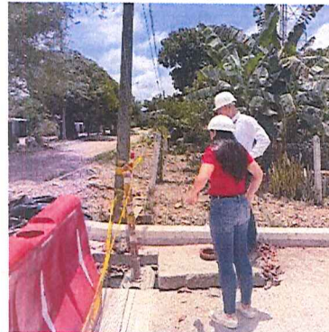
Registro fotográfico de Visita de obra
